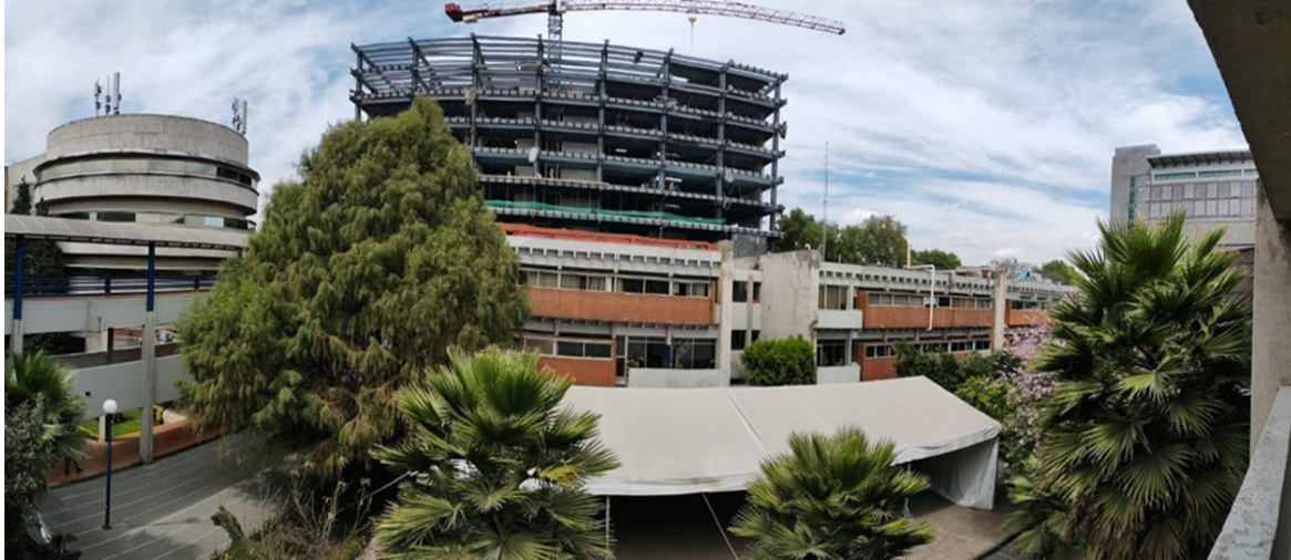
Foto panorámica de la Nueva Torre de Hospitalización, vista desde el interior del Instituto.
