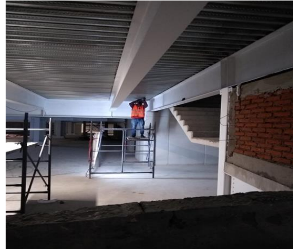
Trabajos en sótanos
