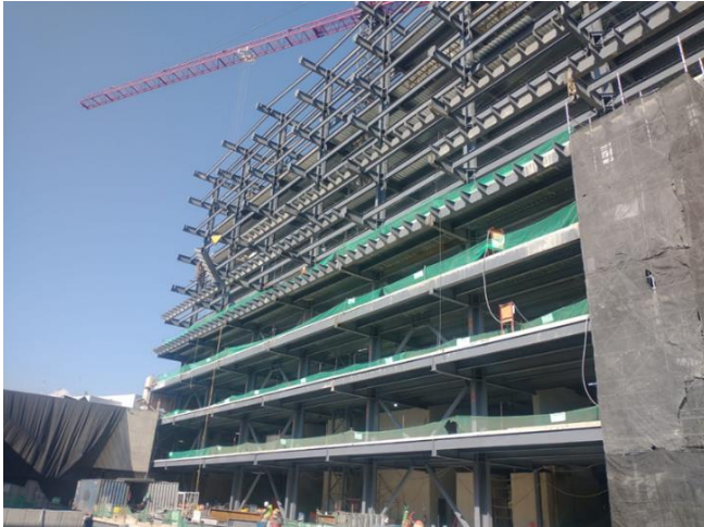
Colocación de acero para fachadas.
