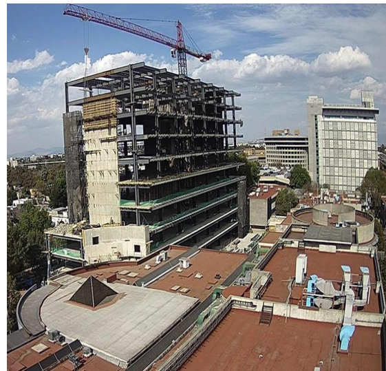
Colocación de acero
